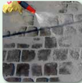
diagonal zur Fuge abreinigen
