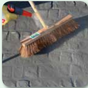
Erhärten des Mörtels auf der Oberfläche vermeiden
